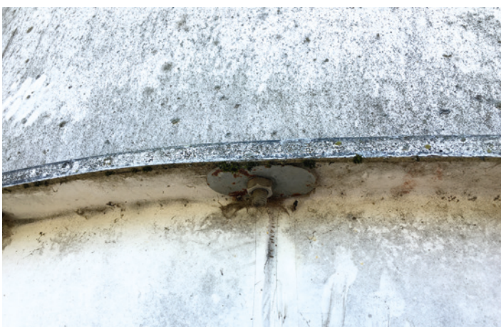
Abb. 6: Undichtes Silo
