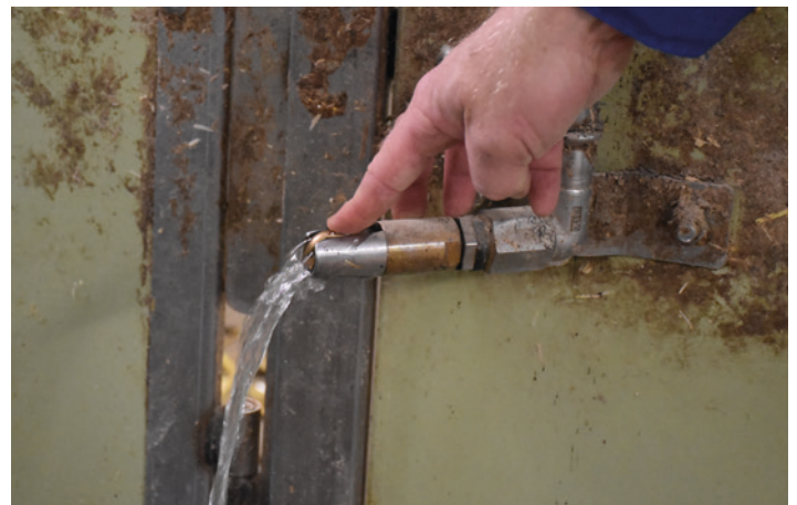
Abb 7: Kontrolle der Durchflussrate
